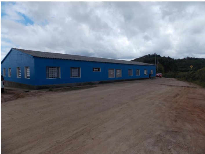
Escola La Salle – vista externa
