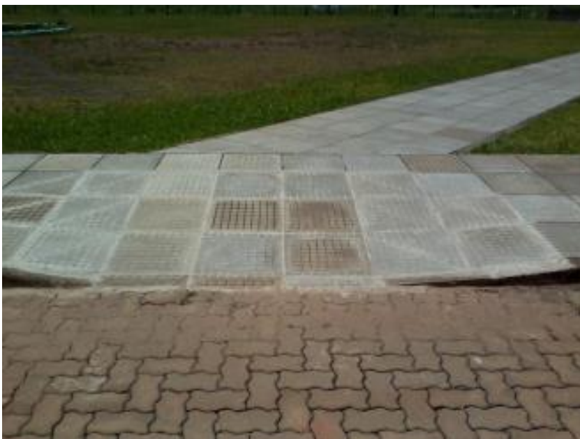
Figura II – Rampa para acesso a cadeirantes.
