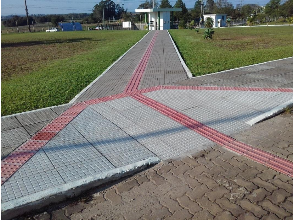
Figura 2 – Rampa para acesso a cadeirantes.
