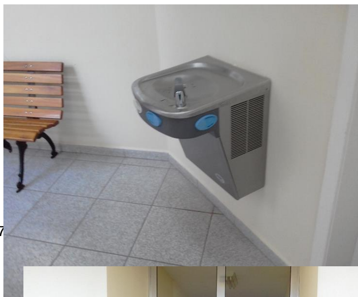
Figura 6 – Bebedouro com acessibilidade é projetado para atender pessoas com deficiência física e mobilidade reduzida.
