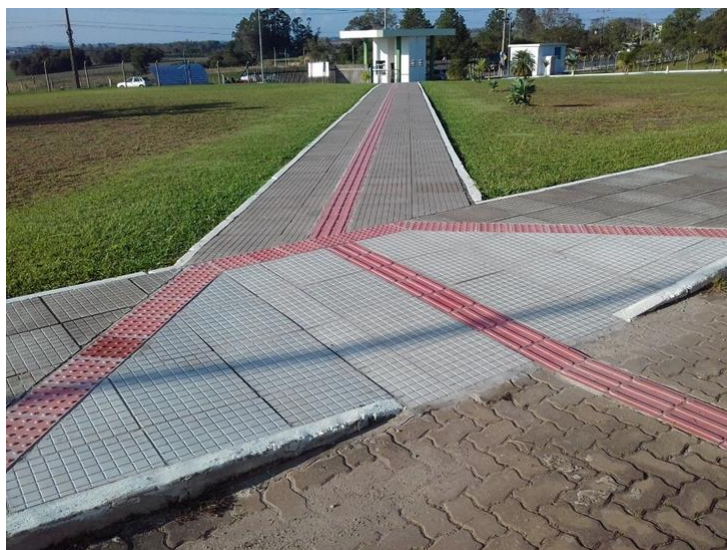
Figura 2 – Rampa para acesso a deficientes físicos.
