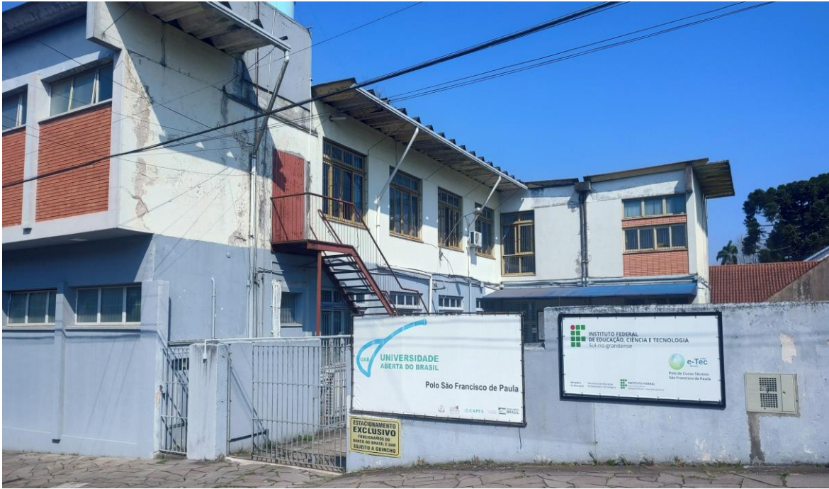
Fachada do prédio
