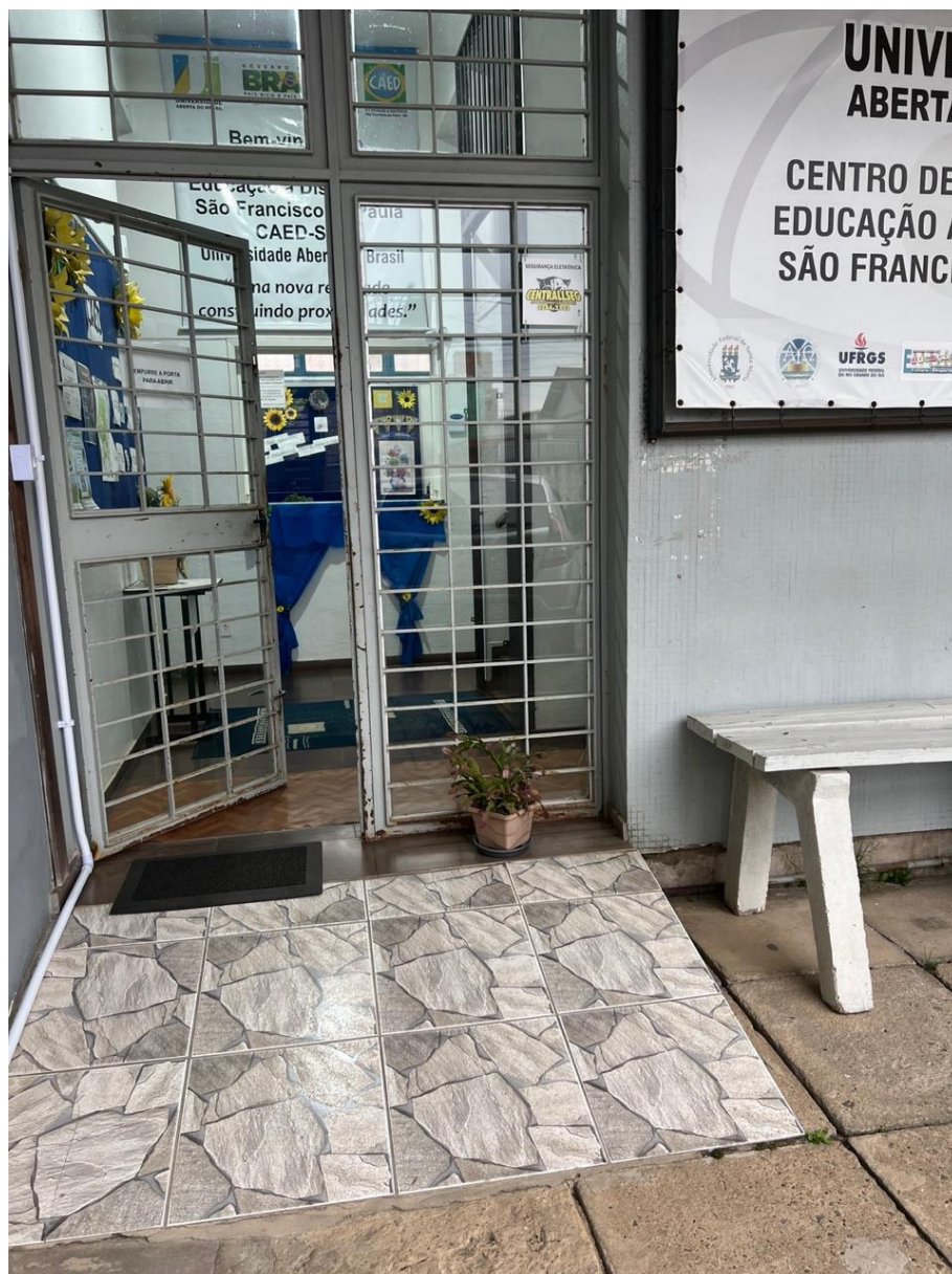
Rampa de acesso - acessibilidade
