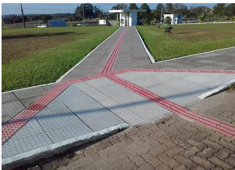
Figura 2 - Rampa para acesso a cadeirantes Fonte: IFSul, Câmpus Venâncio Aires
