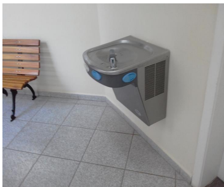
Figura 6 – Bebedouro com acessibilidade é projetado para atender pessoas com deficiência física e mobilidade reduzida.
