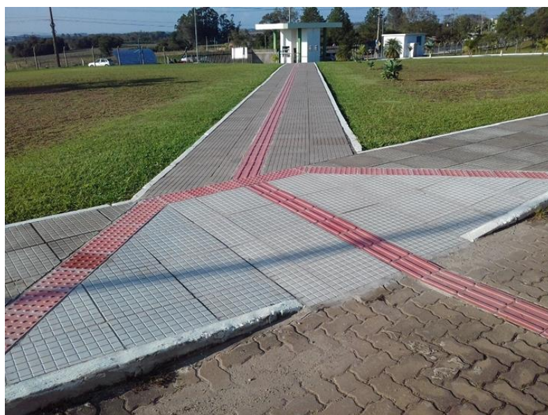
Figura 2 - Rampa para acesso a deficientes físicos.
